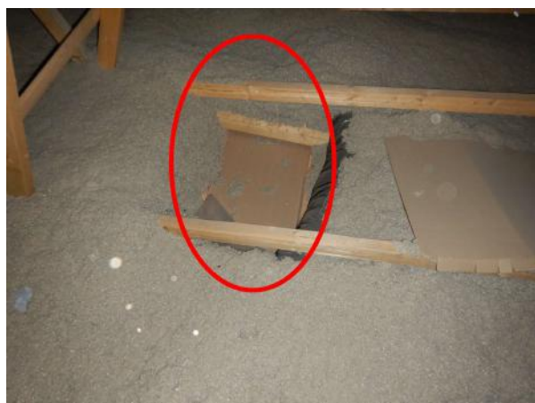
Isolant déplacé dans les combles
