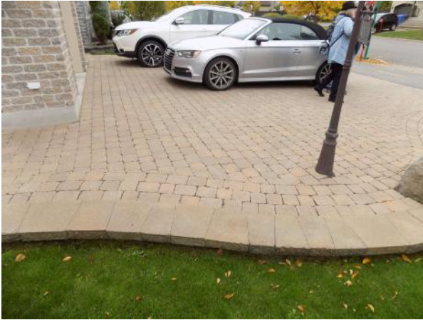
Stationnement et trottoir
