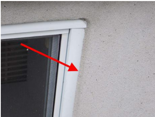
Scellant manquant au pourtour des fenêtres du sous-sol
