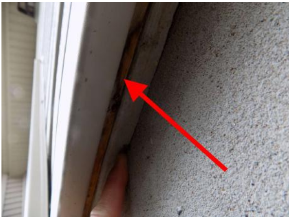
Fourrure horizontale à la base du revêtement de vinyle
