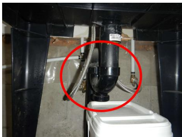
Présence d'un siphon en S sous la cuve du garage
