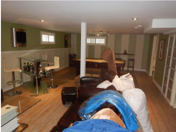
Isolation et pare-vapeur des murs non visibles
